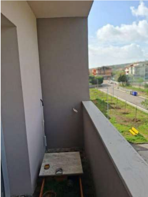
Vista del balcone anteriore
