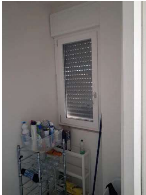
Vista del ripostiglio
