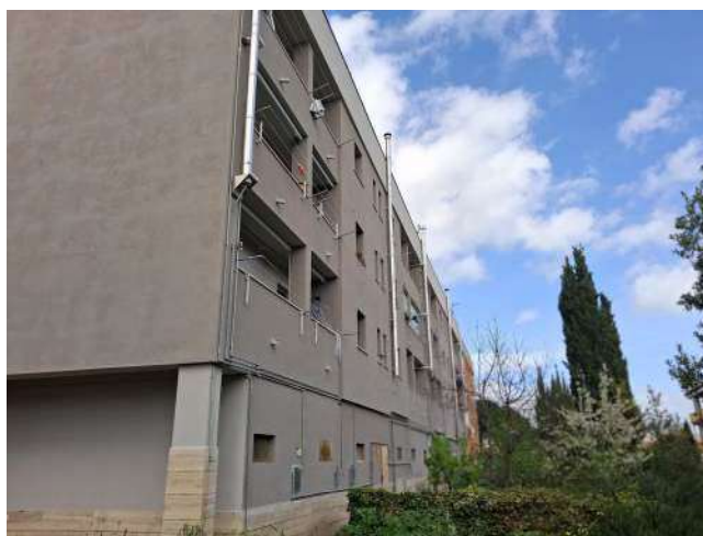
Vista posteriore del fabbricato
