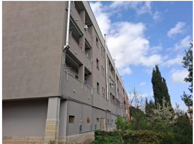
Vista posteriore del fabbricato
