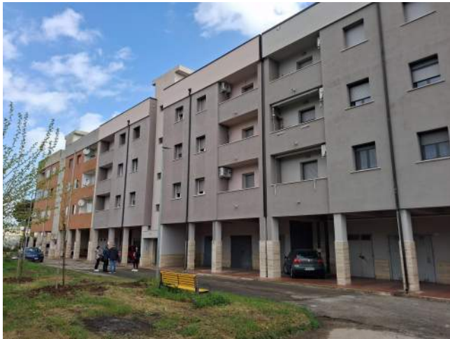
Vista anteriore del fabbricato
