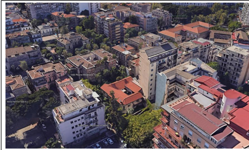
❖ Vista aerea con individuazione del fabbricato
