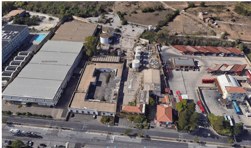
❖ Vista aerea con individuazione del fabbricato
