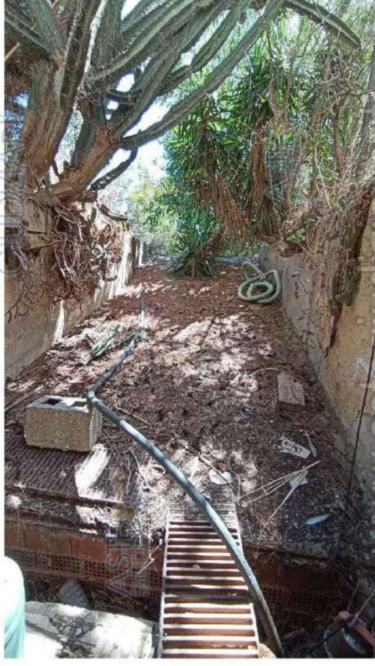
Sopralluogo del 06/08/2021 ABITAZIONE – PIANO SEMINTERRATO – RAMPA DI ACCESSO
