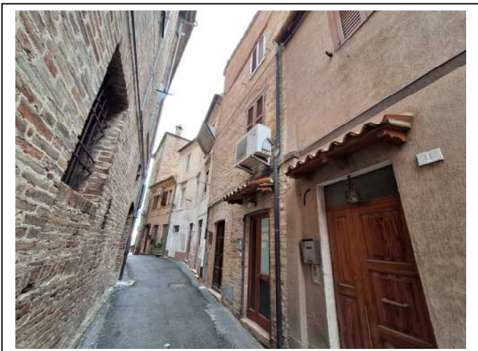
FOTO n°4 – Vista del fronte principale (lato opposto)
