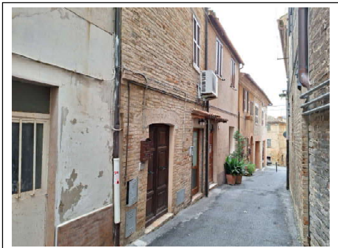
FOTO n°3 – Vista del fronte principale (da ingresso via)
