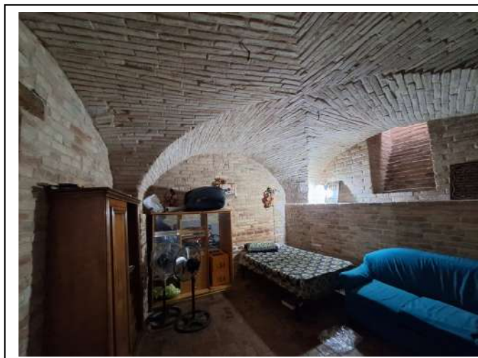
FOTO n°11 – Altra vista stanza piano terra
