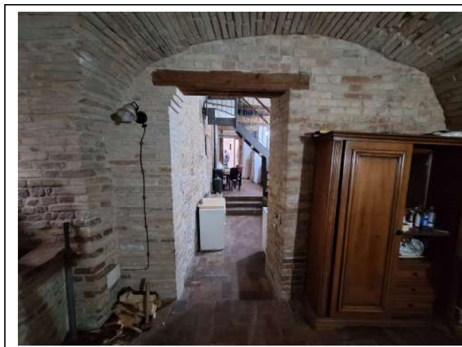
FOTO n°12 – Vista ingresso ultima stanza PT
