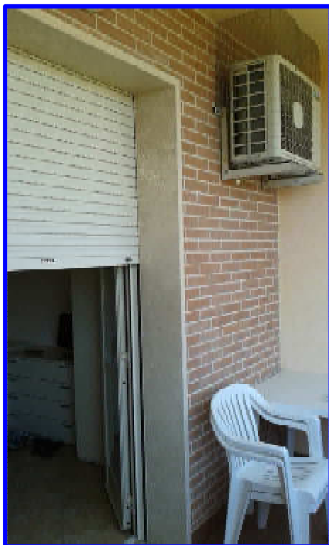
Particolare della loggia con vista della porta d'ingresso dalla camera
