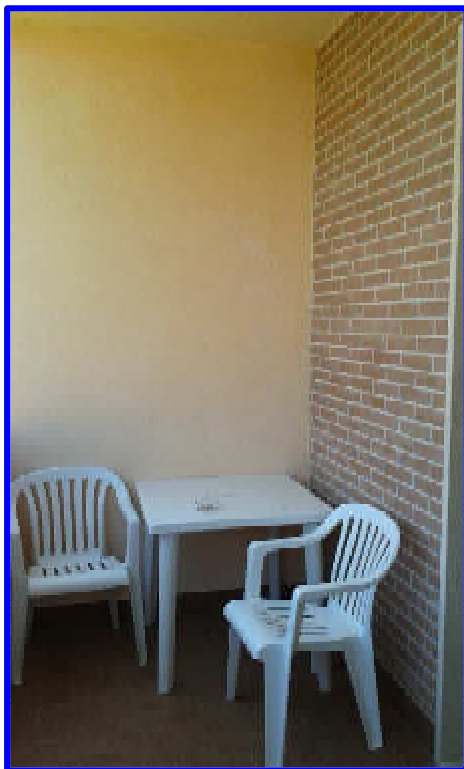
Particolare della loggia
