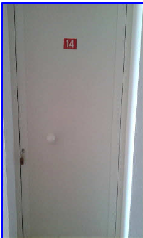
Vista della porta di accesso all'appartamento tipo
