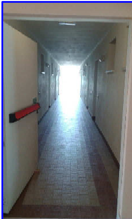
Particolare del corridoio1 dal disimpegno
