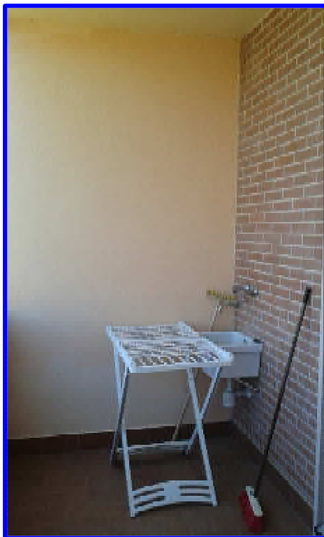
Particolare della loggia
