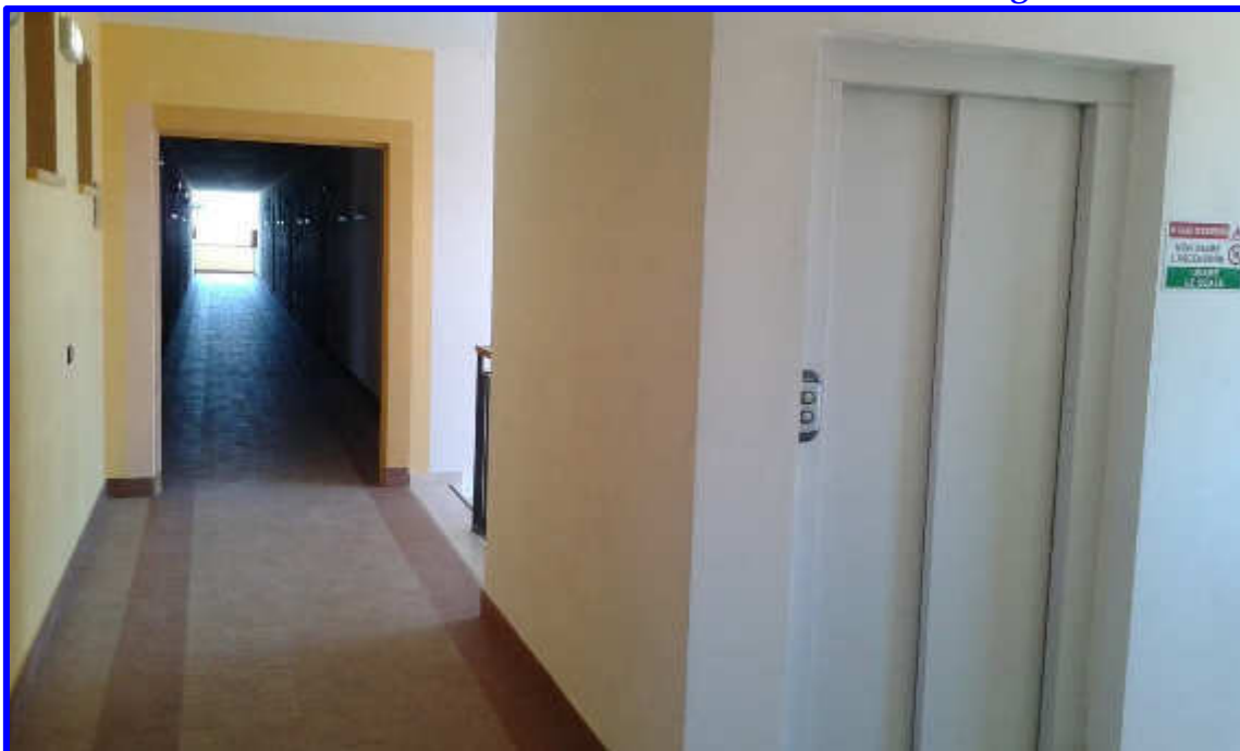
Particolare del disimpegno con vista della porta d'ingresso al corridoio2 e al vano ascensore
