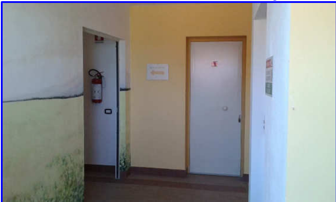
Particolare del disimpegno con vista della porta d'ingresso al corridoio1
