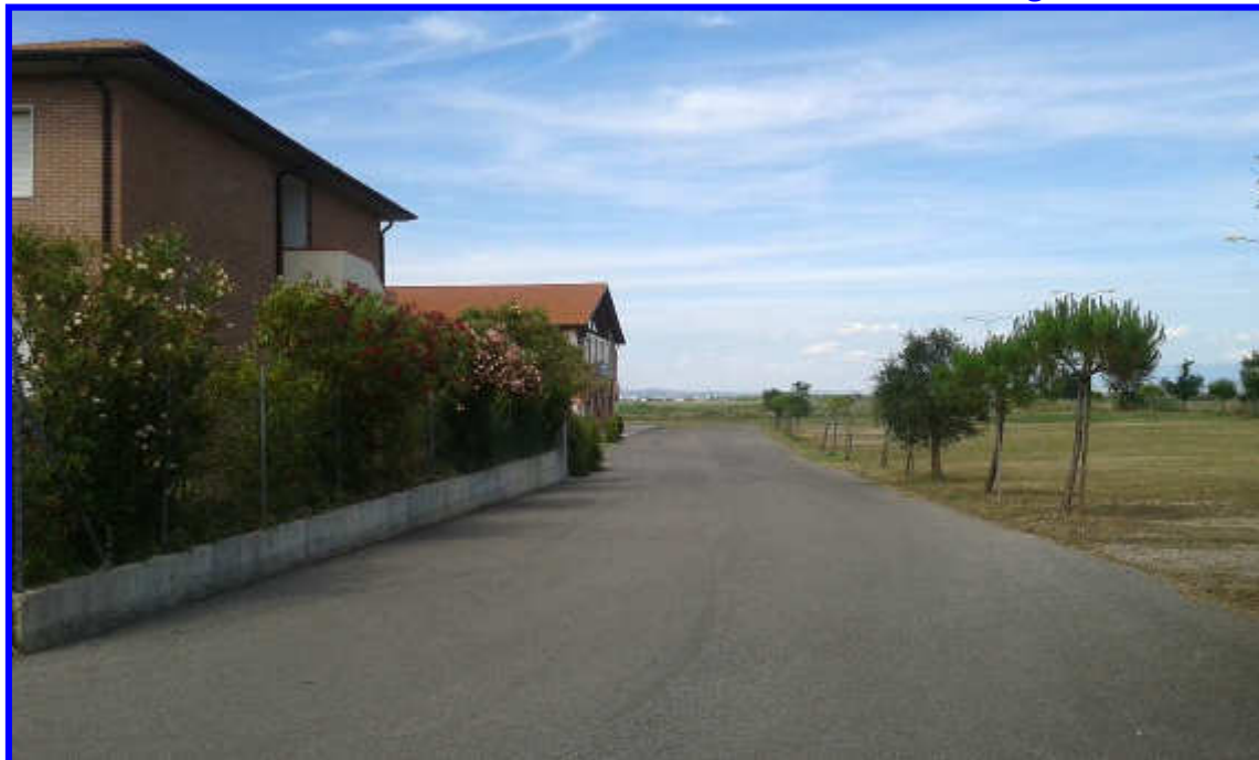
Vista laterale dei fabbricati dalla strada privata
