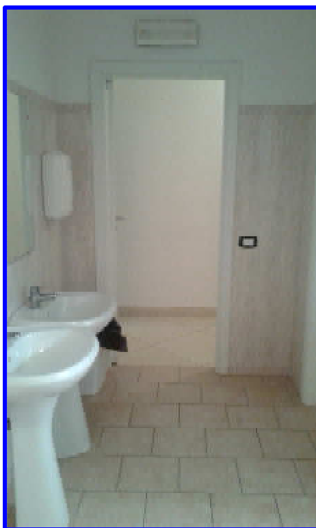
Particolare del disimpegno3 con vista della porta d'ingresso dal disimpegno2
