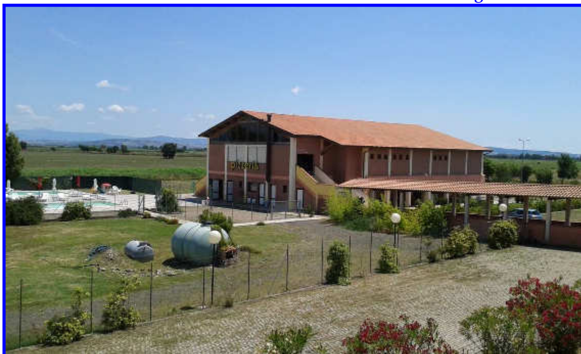
Vista frontale/laterale del Ristorante/Bar dalla R.T.A.
