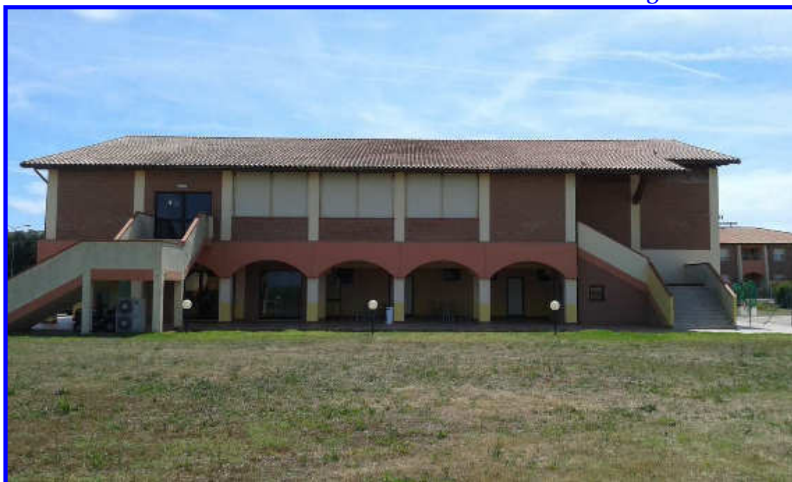
Vista retro del Ristorante/Bar dal terreno di proprietà
