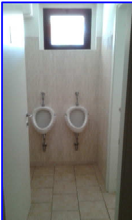
Particolare del disimpegno4 dalla porta d'ingresso dal disimpegno3
