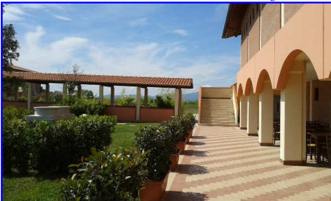
Particolare della corte privata tra il Ristorante/Bar e la R.T.A.
