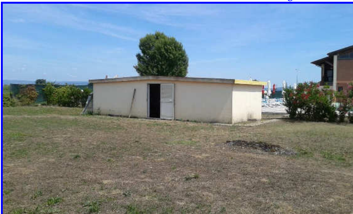
Particolare del locale tecnico per le piscine
