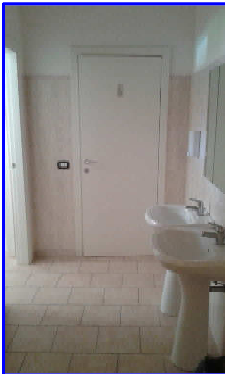
Particolare del disimpegno3 dalla porta d'ingresso dal disimpegno2
