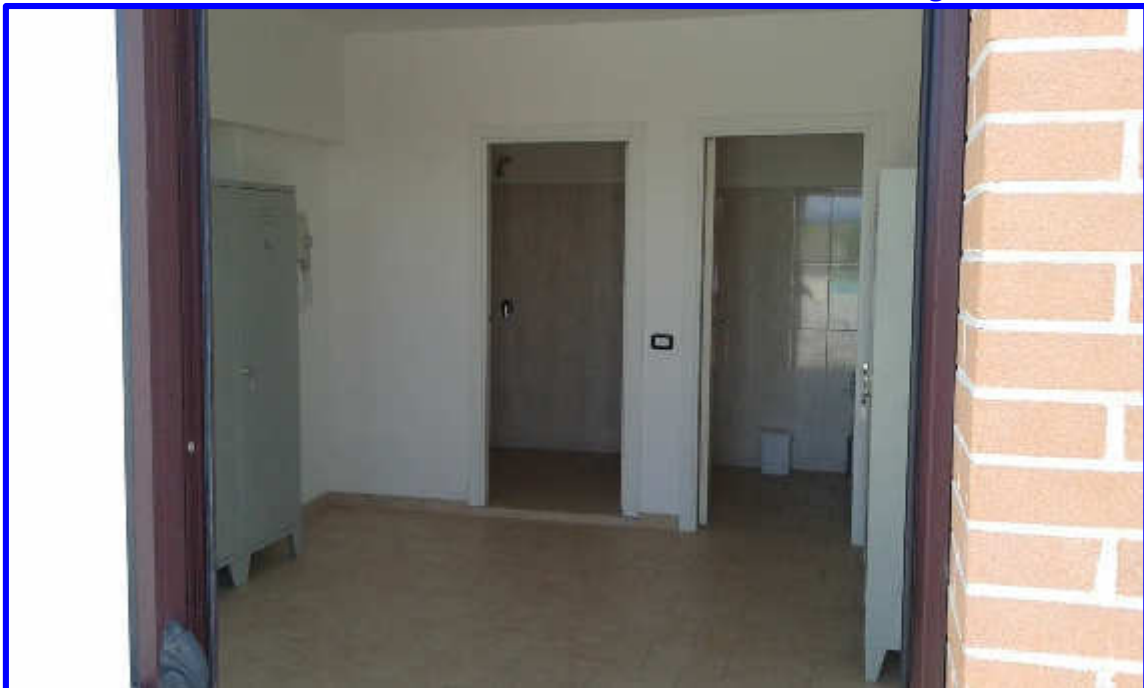
Particolare dello spogliatoio1 dalla porta d'ingresso dalla corte privata con vista delle porte di accesso al bagno1 e al vano docce1
