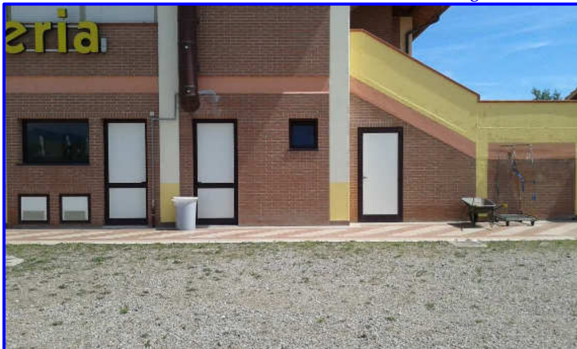
Vista delle porte d'ingresso al sottoscala1 e alla cucina dalla corte privata
