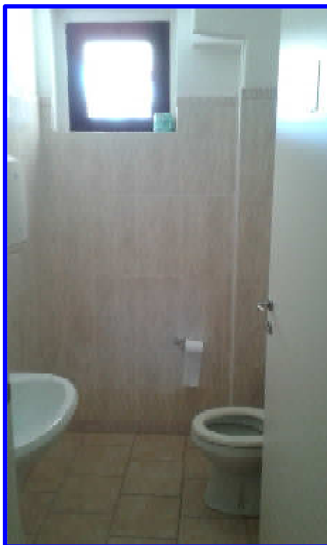
Particolare del bagno4 dalla porta d'ingresso dal disimpegno3
