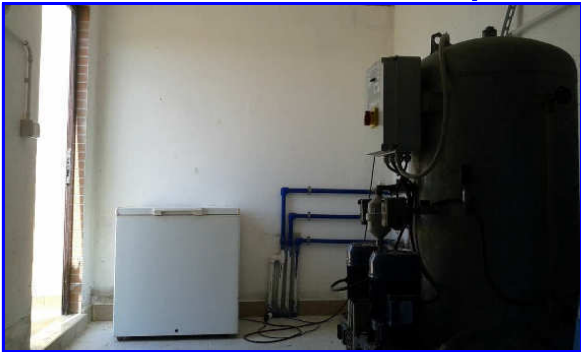
Particolare del sottoscala1 con vista della porta d'ingresso dalla corte privata
