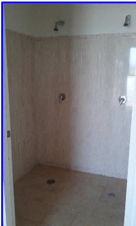
Particolare del vano docce2 dalla porta d'ingresso dallo spogliatoio2
