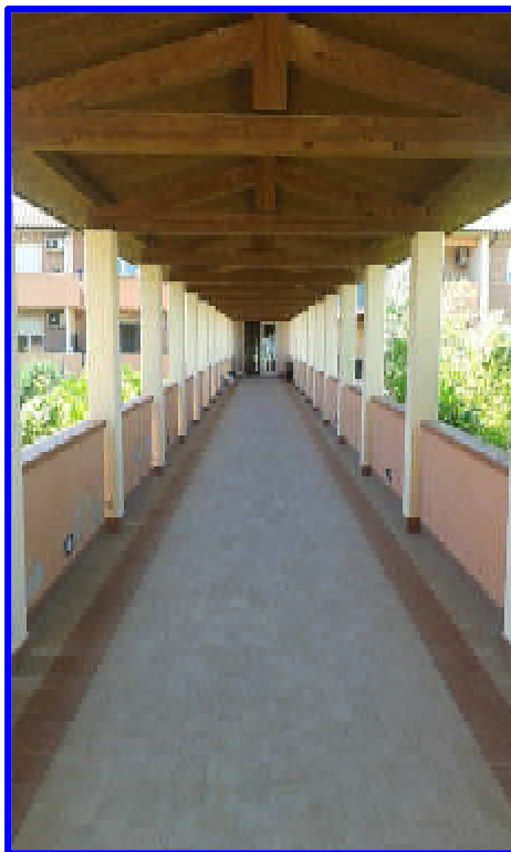
Particolare del portico di collegamento tra il Ristorante/Bar e la R.T.A.
