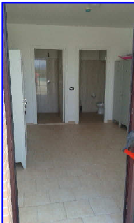
Particolare dello spogliatoio2 dalla porta d'ingresso dalla corte privata con vista delle porte di accesso al bagno2 e al vano docce2
