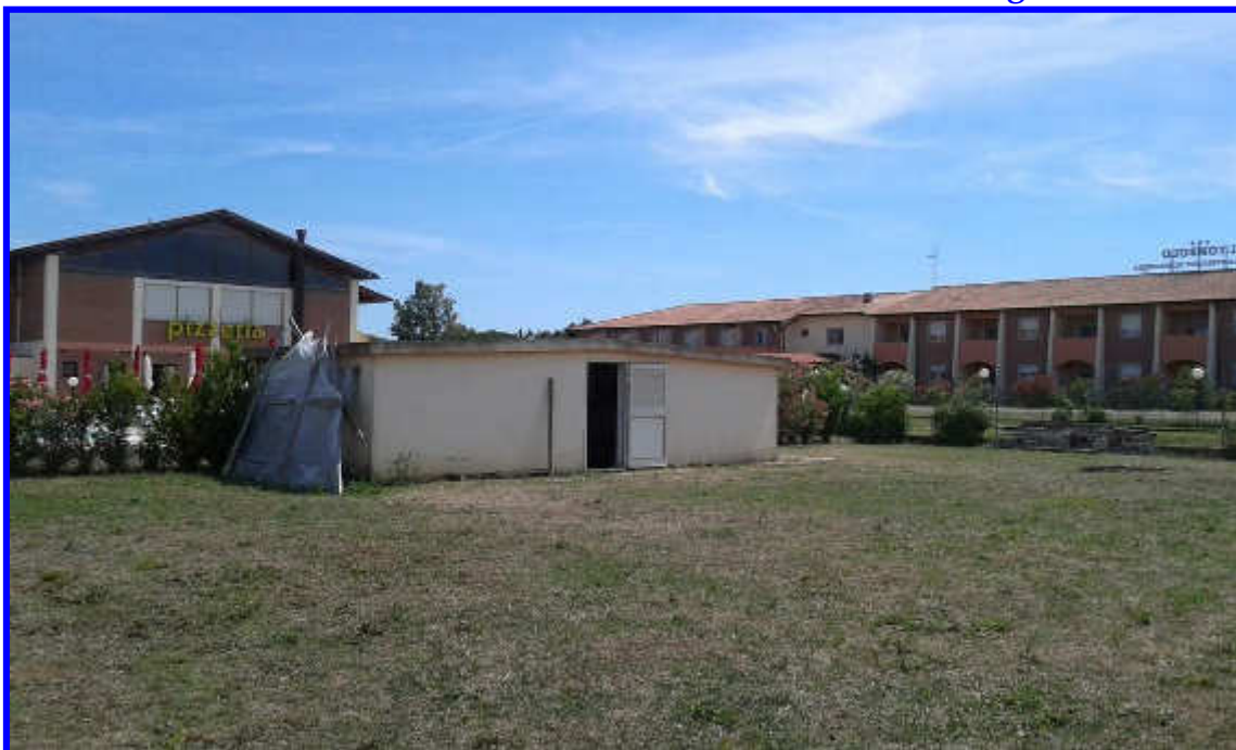
Vista laterale del Ristorante/Bar e del locale tecnico per le piscine dal terreno di proprietà
