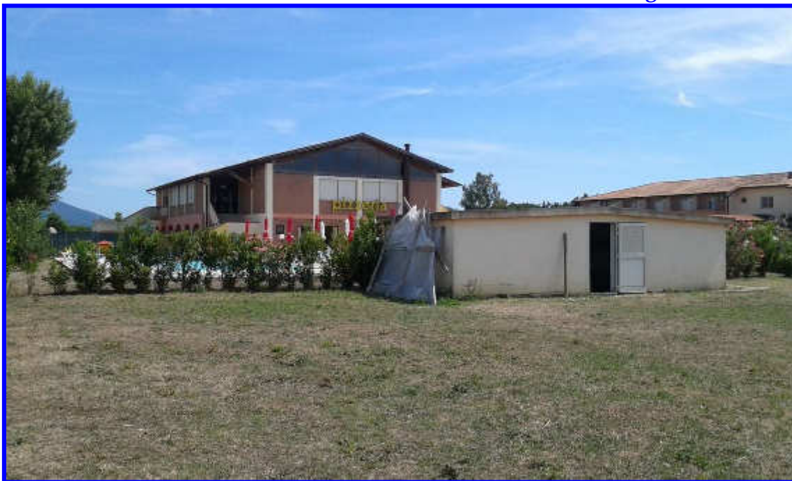
Vista laterale/retro del Ristorante/Bar e del locale tecnico per le piscine dal terreno di proprietà
