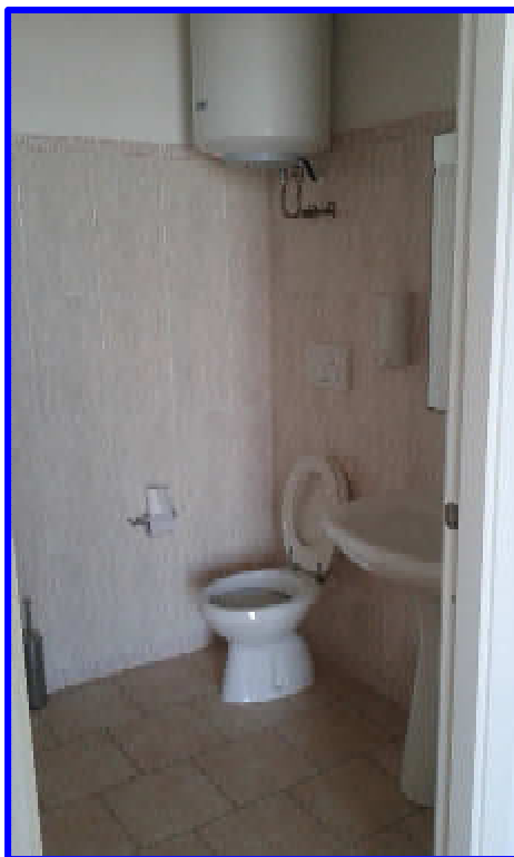
Particolare del bagno2 dalla porta d'ingresso dallo spogliatoio2
