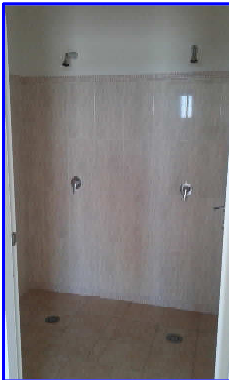
Particolare del vano docce1 dalla porta d'ingresso dallo spogliatoio1
