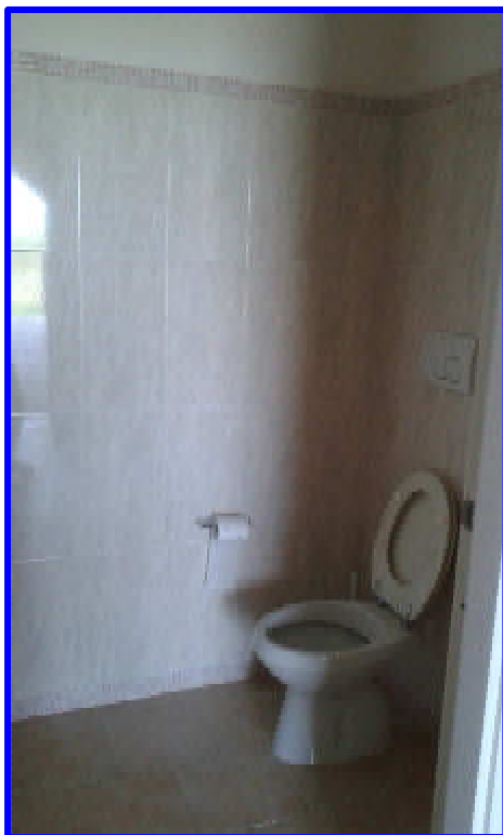
Particolare del bagno10 dalla porta d'ingresso dal disimpegno5
