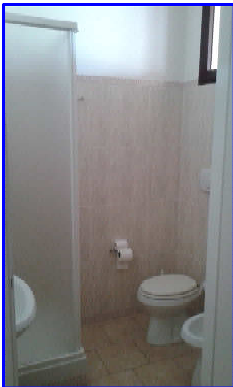
Particolare del bagno7 dalla porta d'ingresso dallo spogliatoio4
