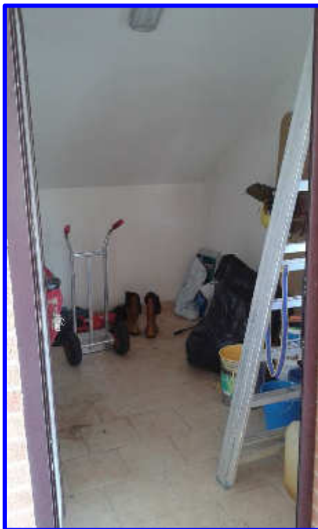
Particolare del sottoscala2 dalla porta d'ingresso dalla loggia
