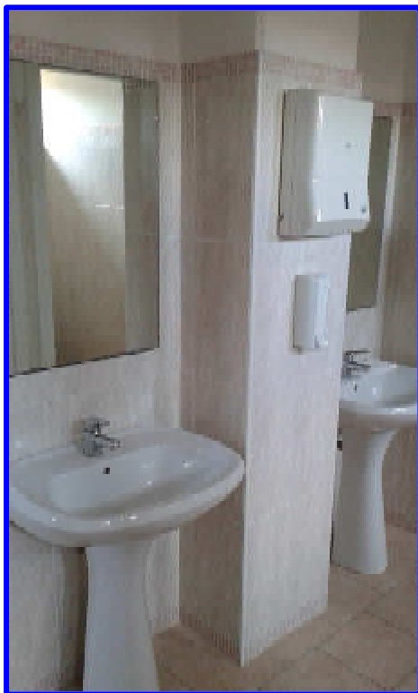
Particolare del bagno2
