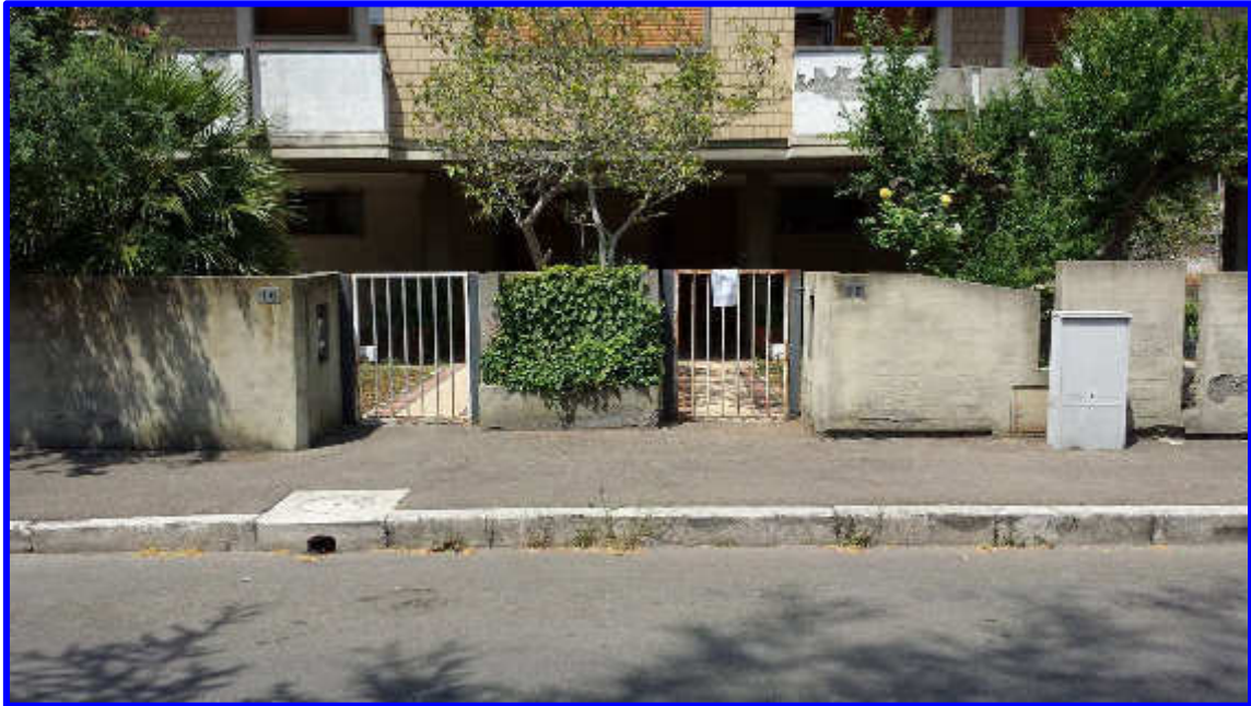
Particolare dei cancelletti d'ingresso alla proprietà da Via Danimarca
