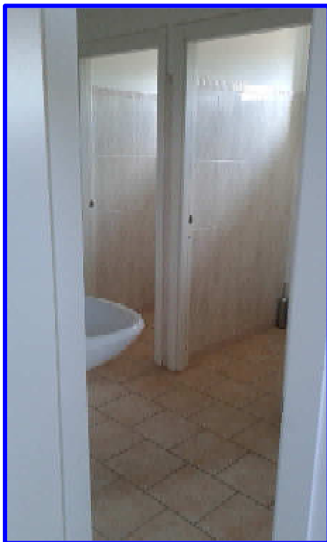
Particolare del bagno2 dalla porta d'ingresso dal disimpegno1
