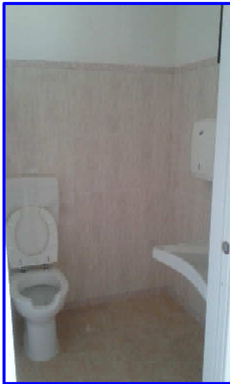
Particolare del bagno9 dalla porta d'ingresso dal disimpegno5
