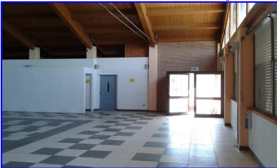
Particolare della terrazza coperta con vista della porta d'ingresso dall'esterno
