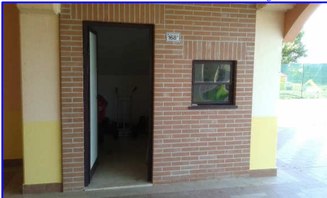
Vista della porta d'ingresso al sottoscala2 dalla loggia
