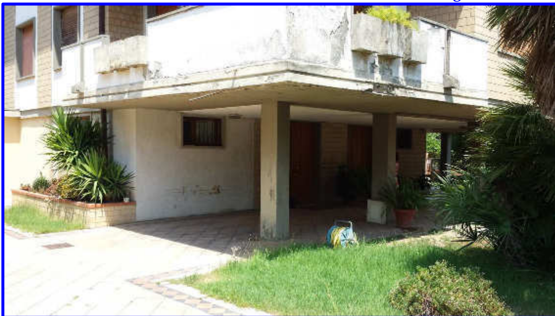
Particolare del porticato dalla corte privata
