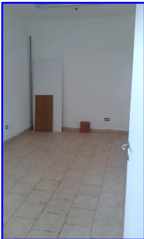
Particolare dello spogliatoio dalla porta d'ingresso dal disimpegno3
