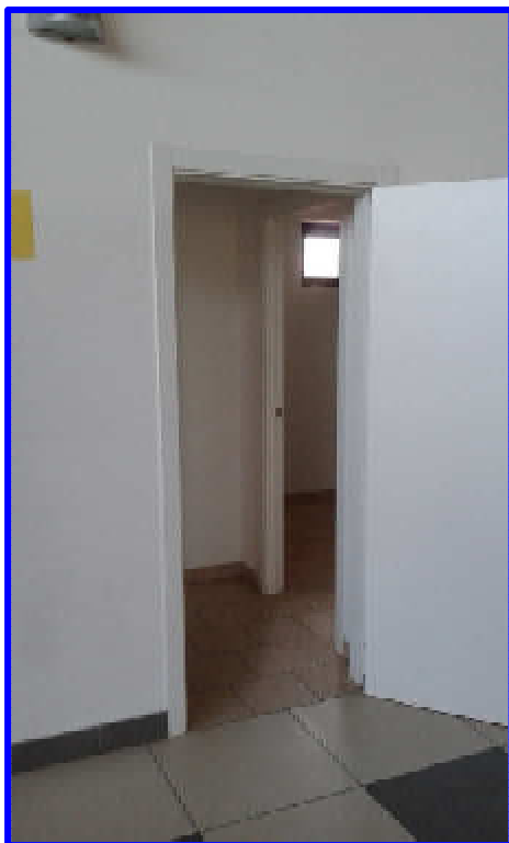
Vista della porta d'ingresso al disimpegno3 dalla terrazza coperta
