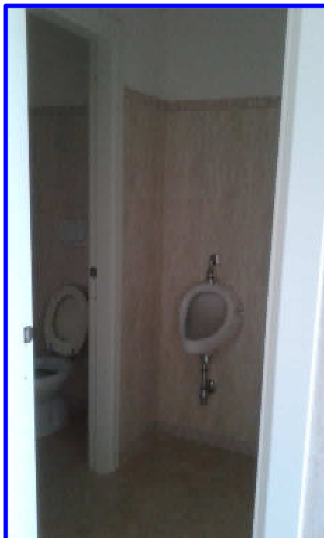
Particolare del disimpegno6 dalla porta d'ingresso dal disimpegno5 con vista della porta d'ingresso al bagno11
