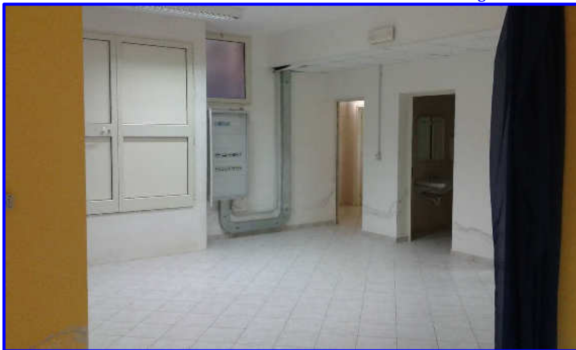
Vista delle porte d'ingresso all'antibagno1 e all'antibagno2
