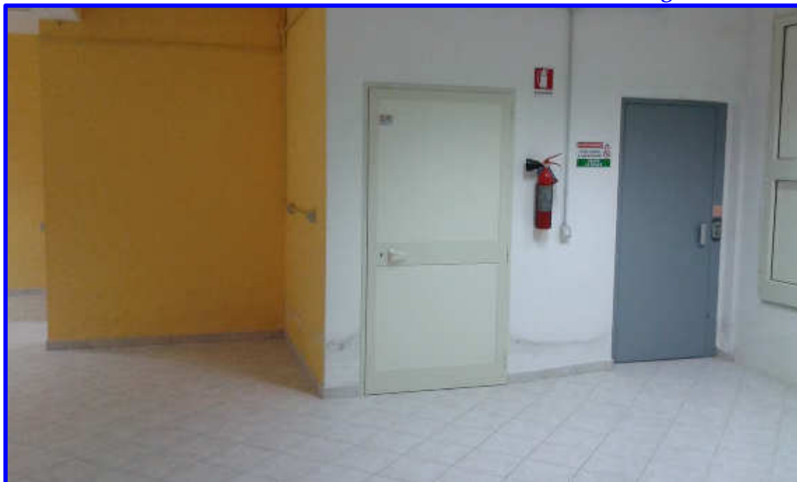
Particolare dei vani ascensori
