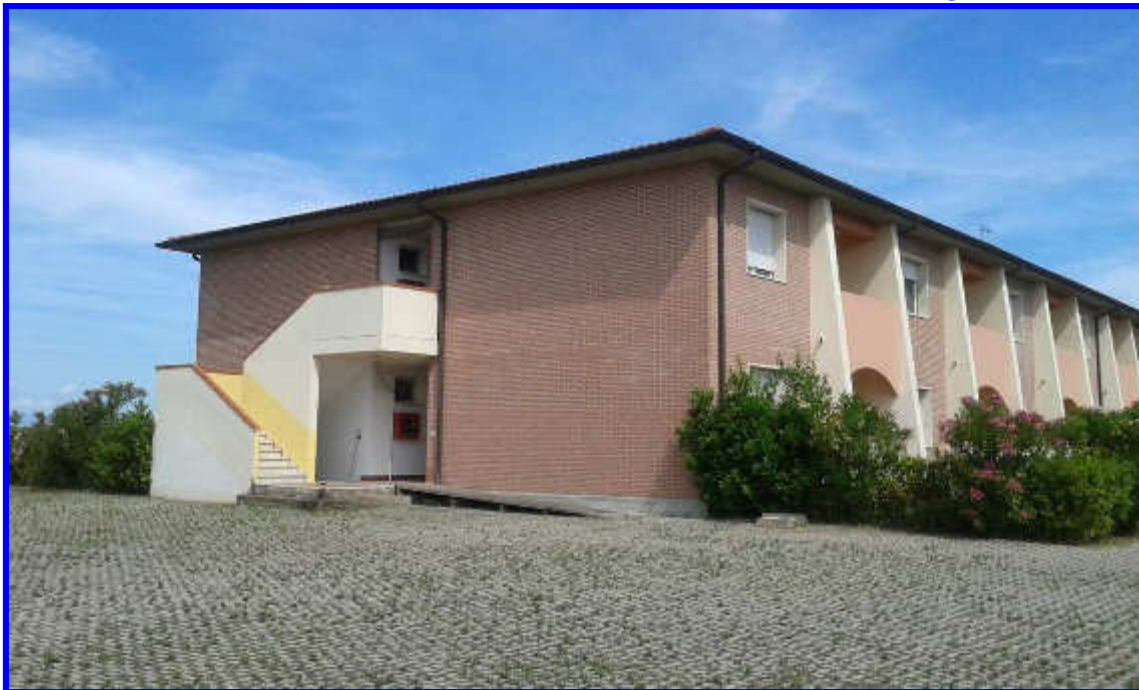
Vista laterale della R.T.A. dalla corte privata
