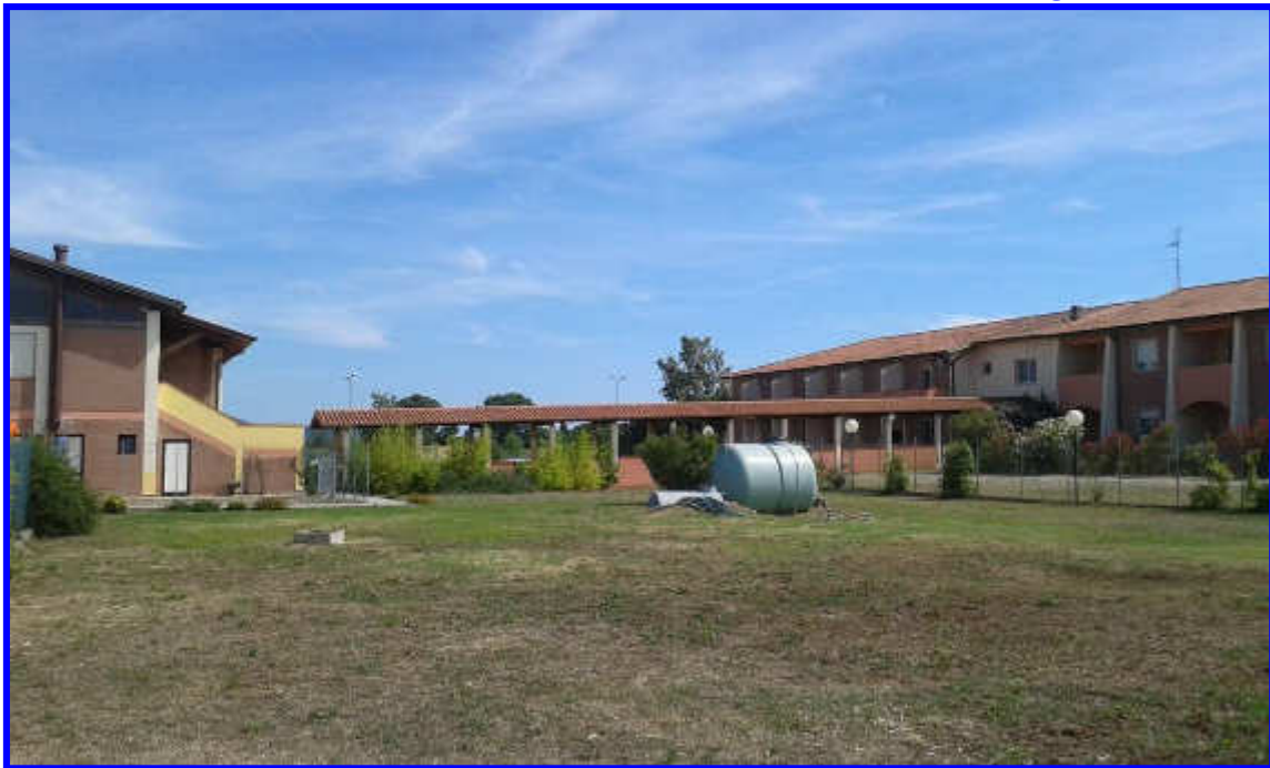
Vista retro della R.T.A. e della tettoia di collegamento con il Ristorante/Bar dal terreno di proprietà
