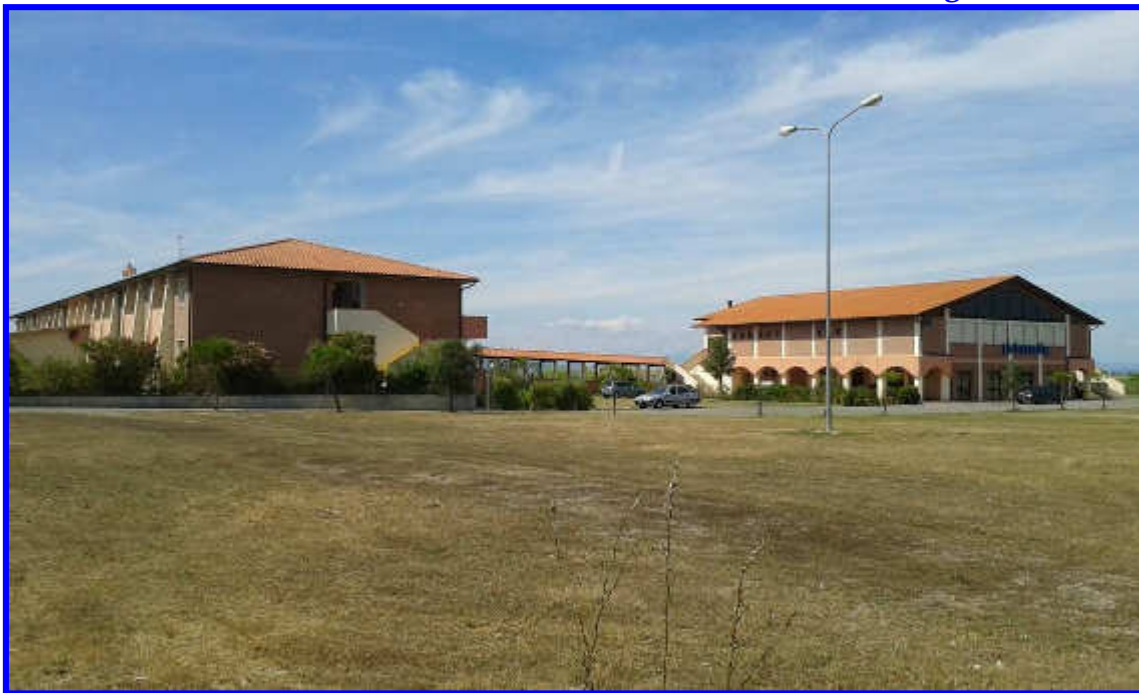
Vista laterale dei fabbricati dal terreno di proprietà
