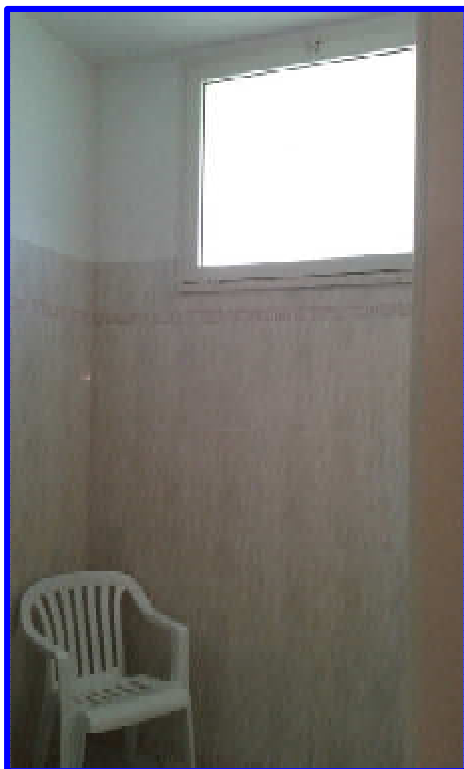
Particolare dell'antibagno1 con vista della finestra
