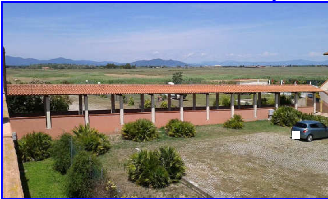
Particolare della tettoia di collegamento con il Ristorante/Bar
