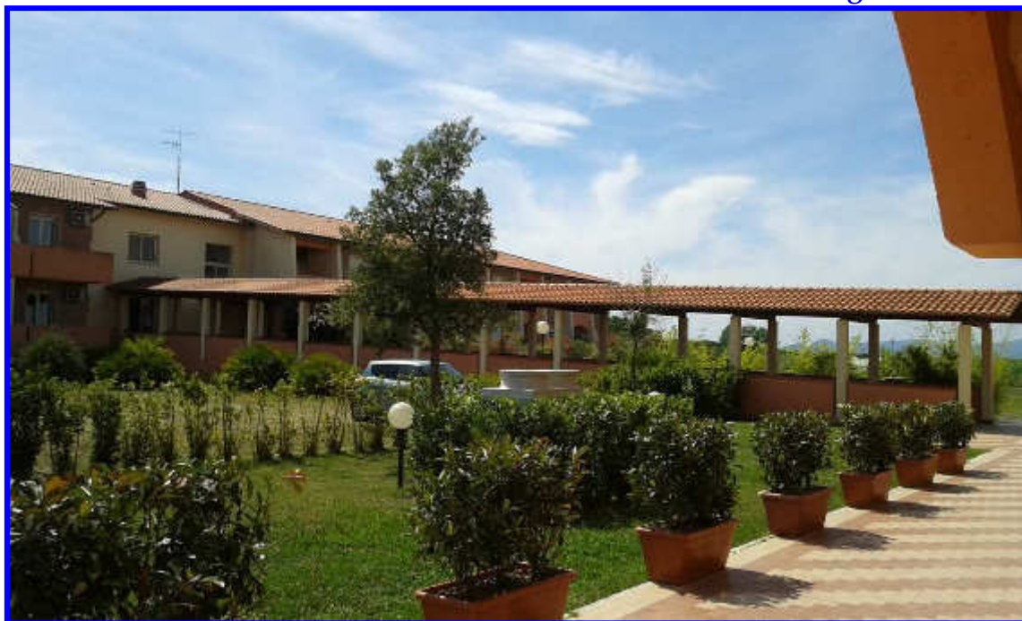
Vista retro del R.T.A. e del camminamento di collegamento con il Ristorante/Bar dalla corte privata
