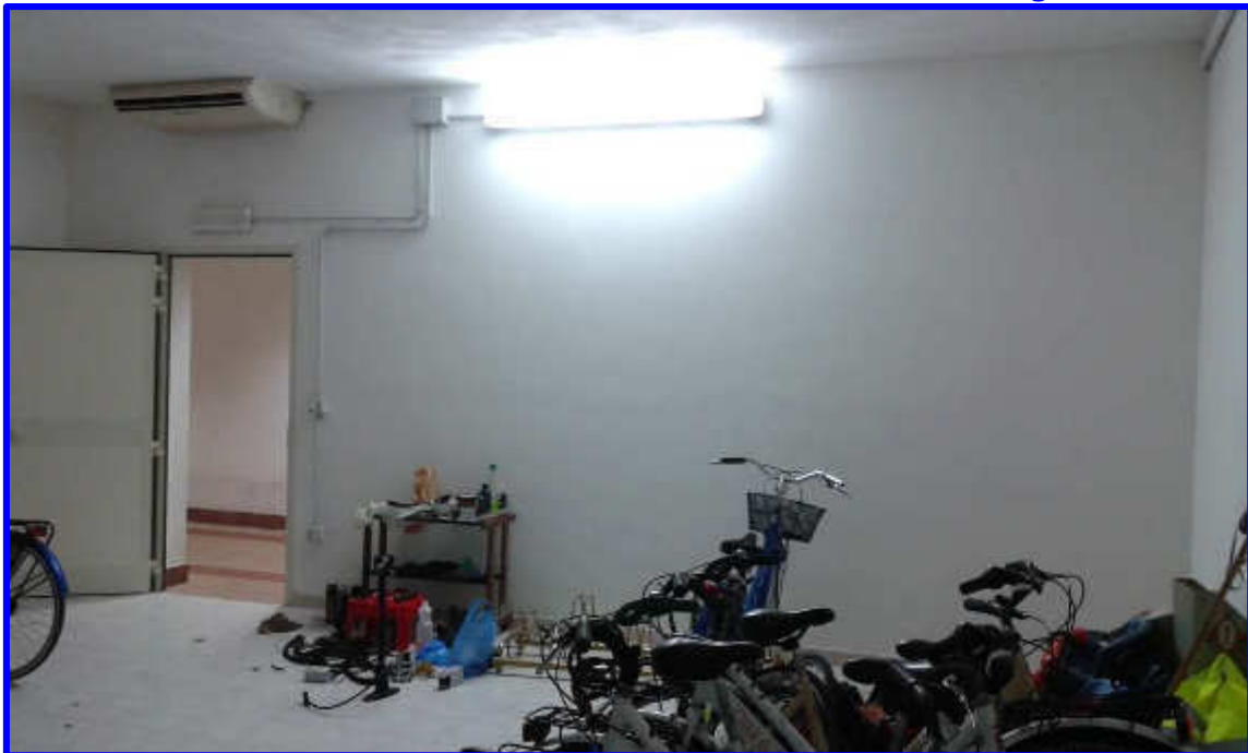
Particolare del deposito2 con vista della porta d'ingresso dal disimpegno
