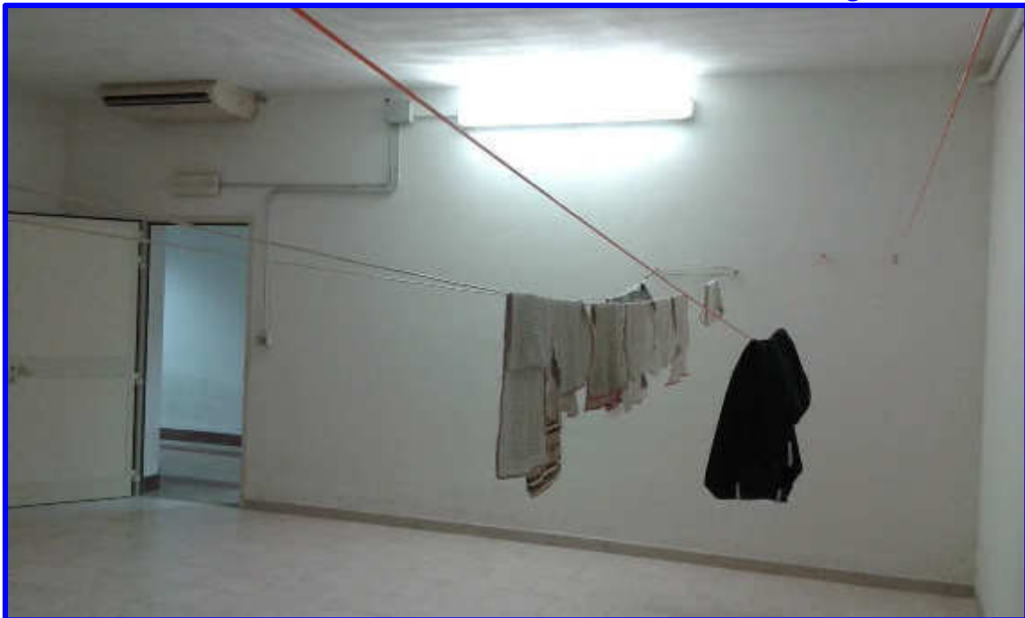
Particolare del deposito3 con vista della porta d'ingresso dal disimpegno
