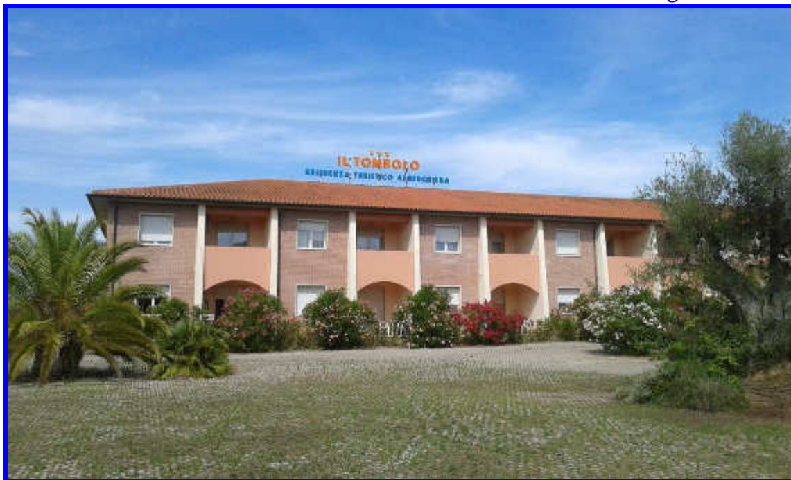
Vista frontale della R.T.A. dalla corte privata
