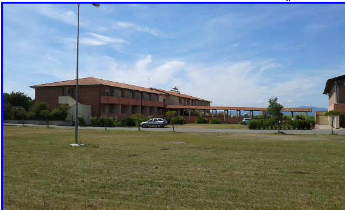
Vista retro del R.T.A. dal terreno di proprietà
