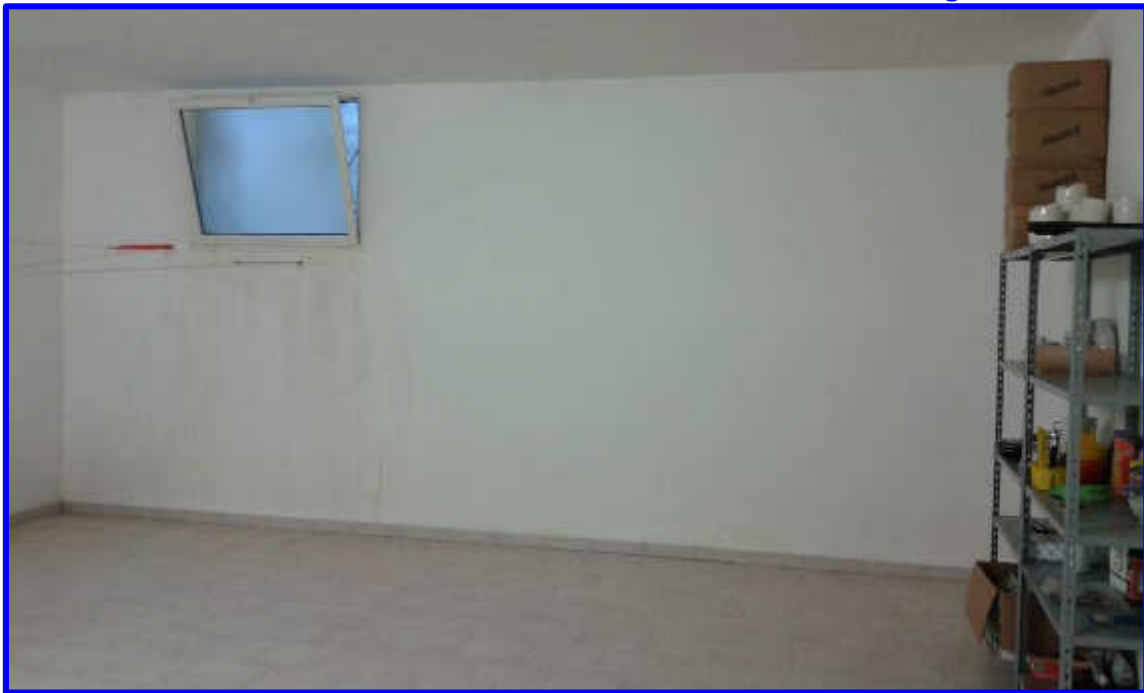
Particolare del deposito3 dalla porta d'ingresso dal disimpegno
