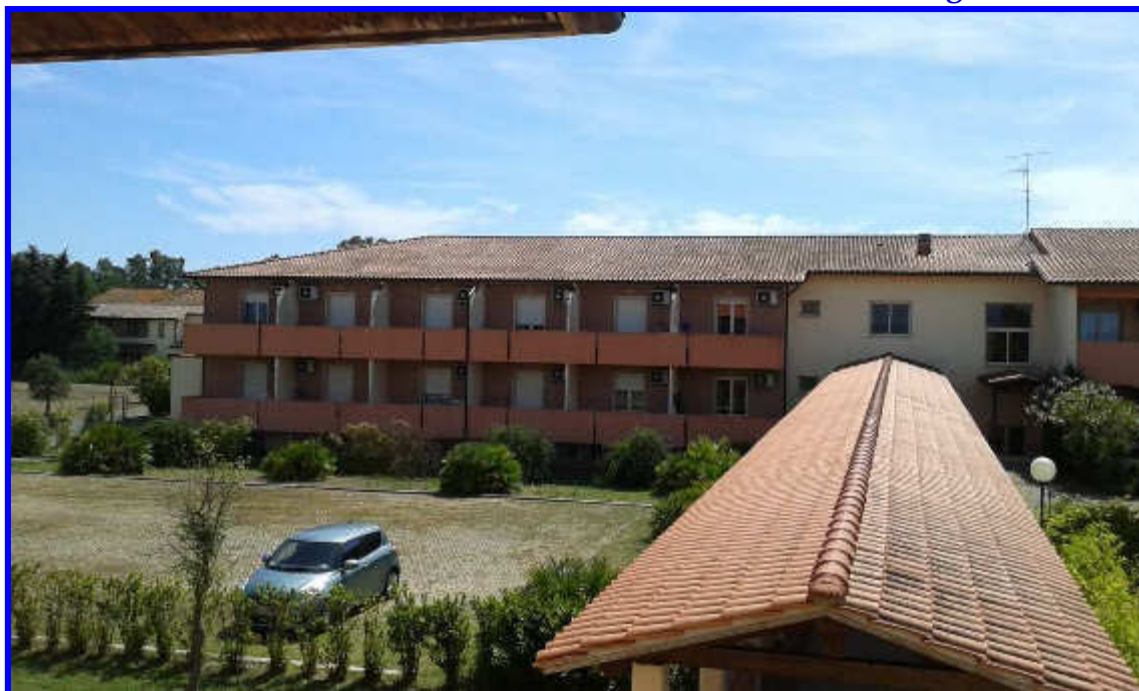
Vista retro della R.T.A. e della tettoia di collegamento con il Ristorante/Bar
