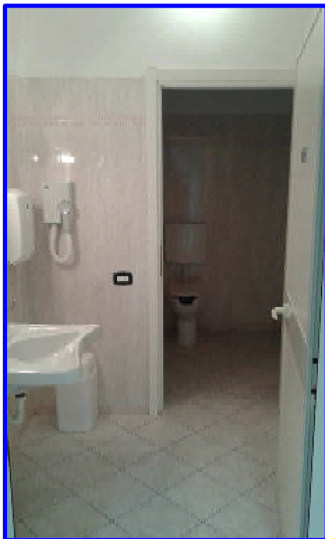
Particolare dell'antibagno2 con vista della porta d'ingresso al bagno3 dalla porta d'ingresso dalla sala riunioni
