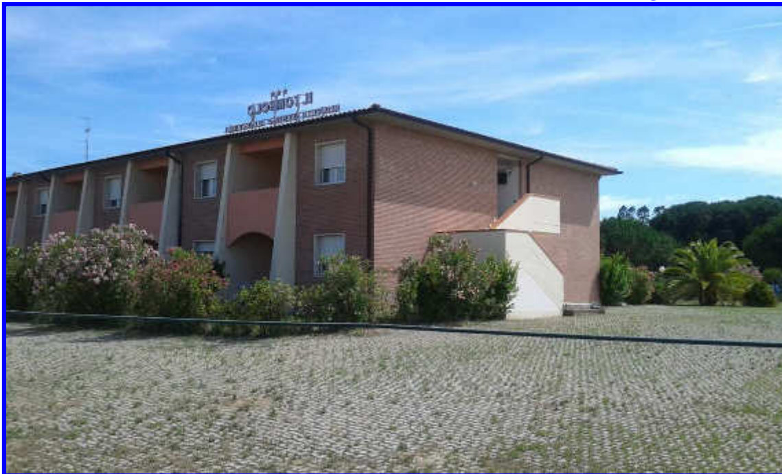
Vista retro e laterale della R.T.A. e dalla corte privata
