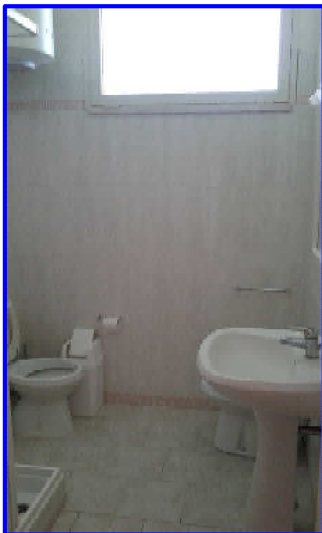
Particolare del bagno5 dalla porta d'ingresso dallo spogliatoio2
