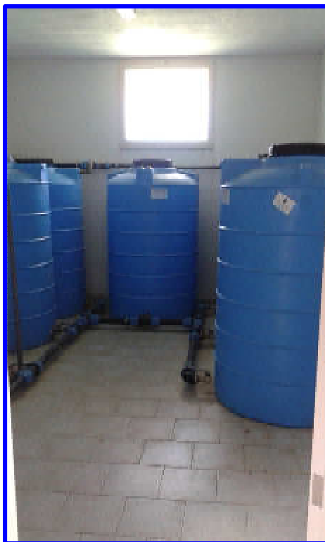
Particolare del vano autoclave dalla porta d'ingresso dal disimpegno
