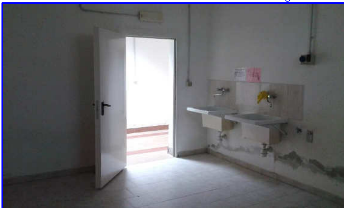
Particolare della lavanderia con vista della porta d'ingresso dal disimpegno
