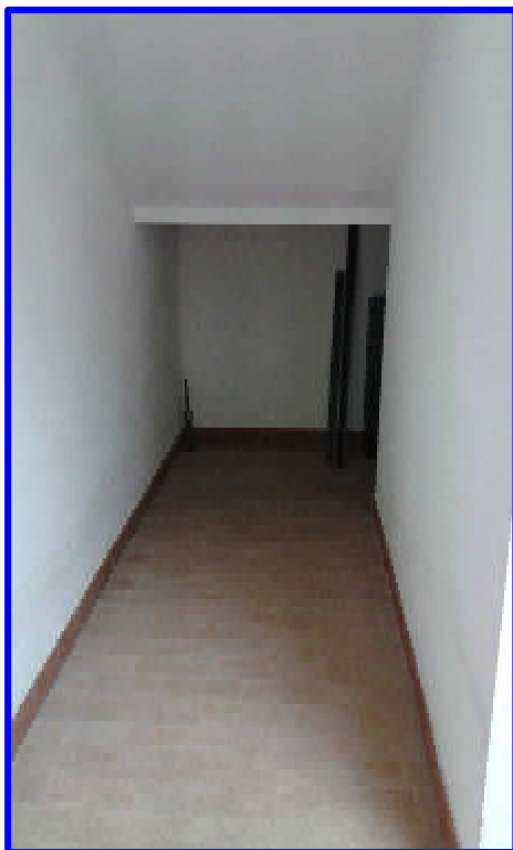
Particolare della sottoscala dal disimpegno
