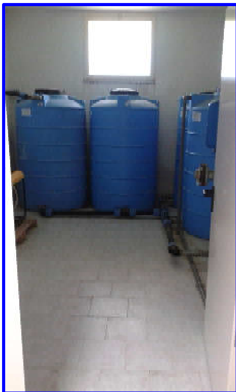
Particolare del vano antincendio dalla porta d'ingresso dal disimpegno
