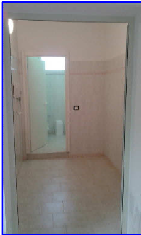
Particolare dello spogliatoio1 con vista della porta d'ingresso al bagno4 dalla porta d'ingresso dal disimpegno
