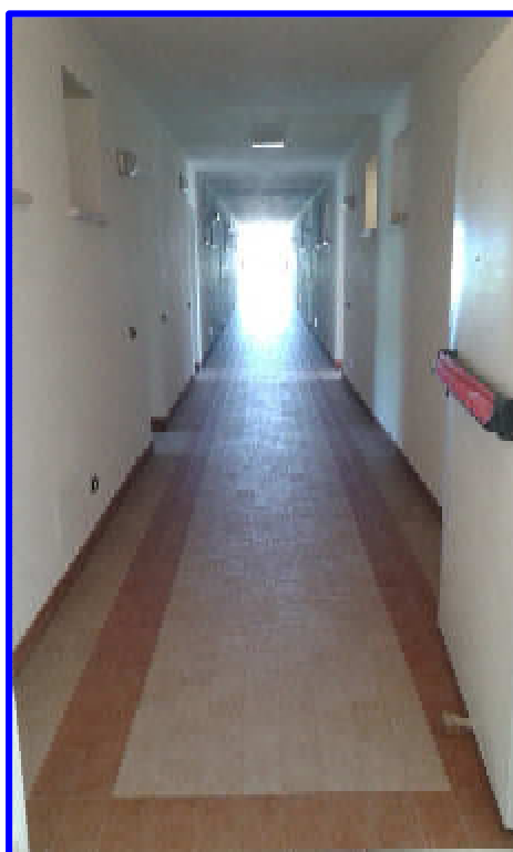
Particolare del corridoio1 dal disimpegno
