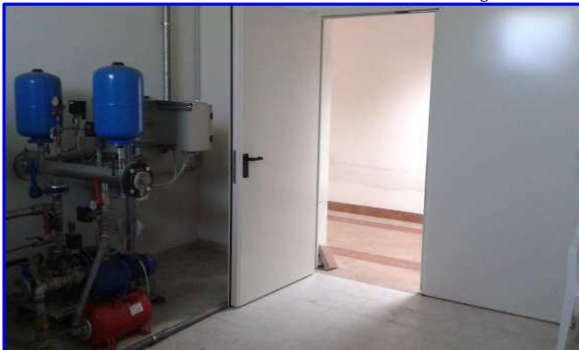
Particolare del vano antincendio con vista della porta d'ingresso dal disimpegno
