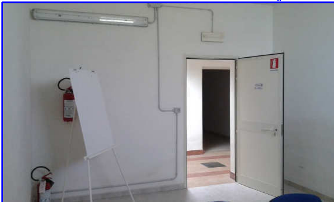
Particolare della stireria con vista della porta d'ingresso dal disimpegno
