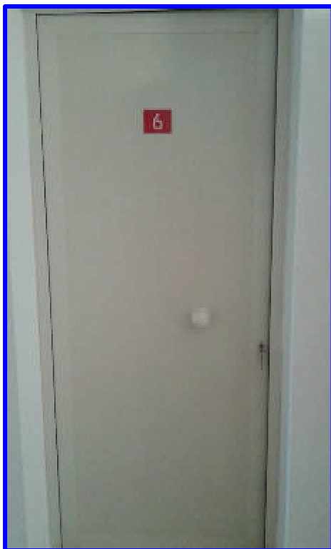
Vista della porta di accesso all'appartamento tipo
