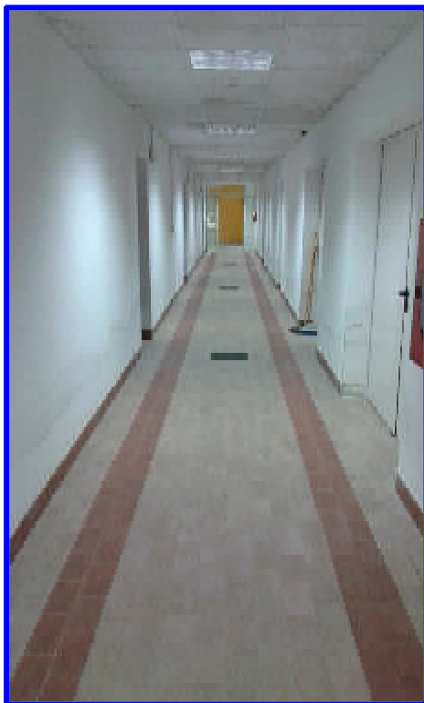
Particolare del disimpegno dalla scala di accesso al piano terra
