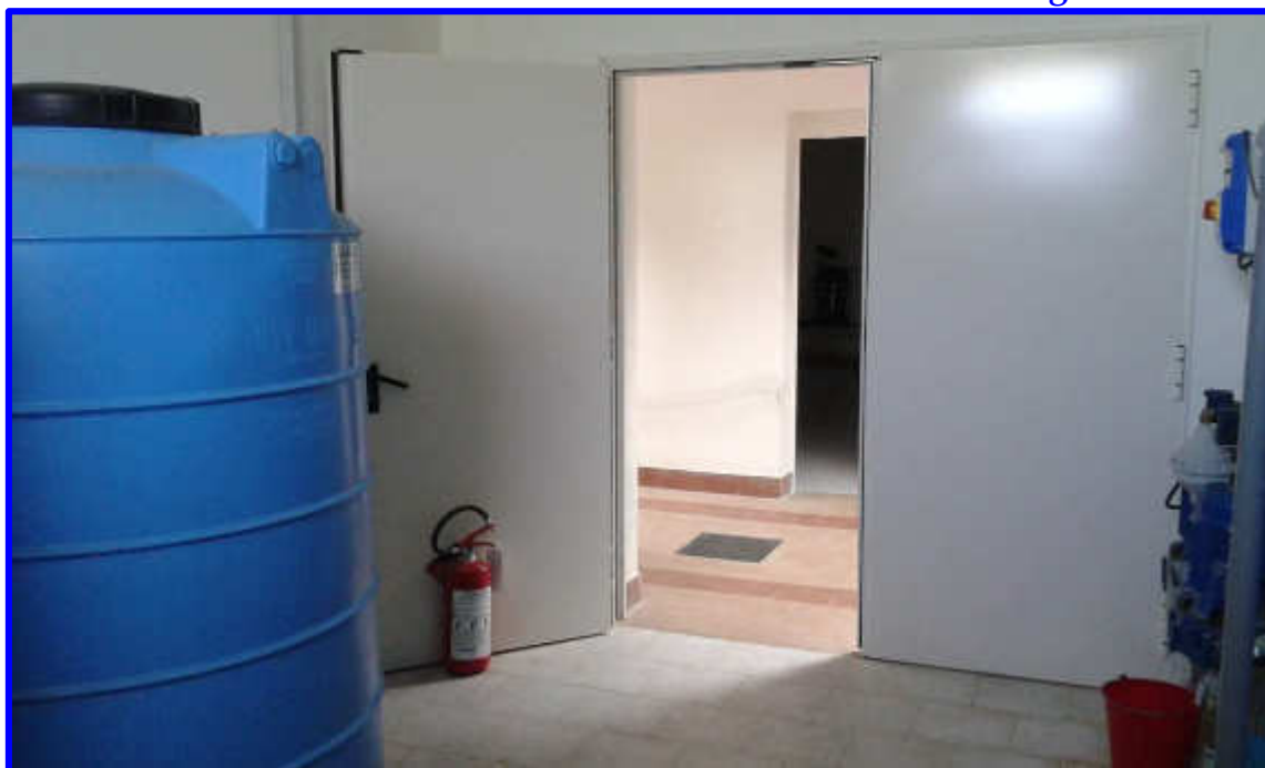
Particolare del vano autoclave con vista della porta d'ingresso dal disimpegno
