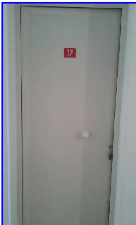
Vista della porta di accesso all'appartamento tipo
