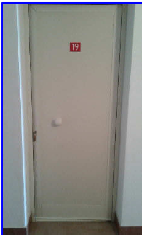
Vista della porta di accesso all'appartamento tipo
