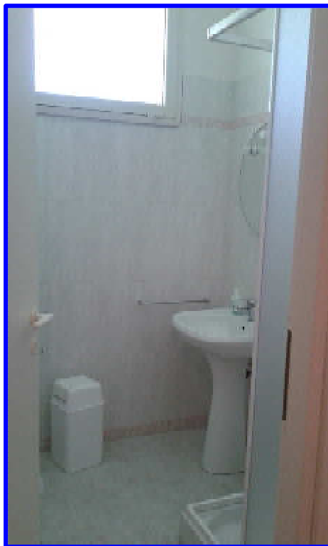
Particolare del bagno4 dalla porta d'ingresso dallo spogliatoio1
