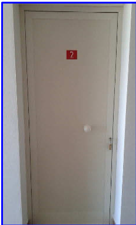
Vista della porta di accesso all'appartamento tipo
