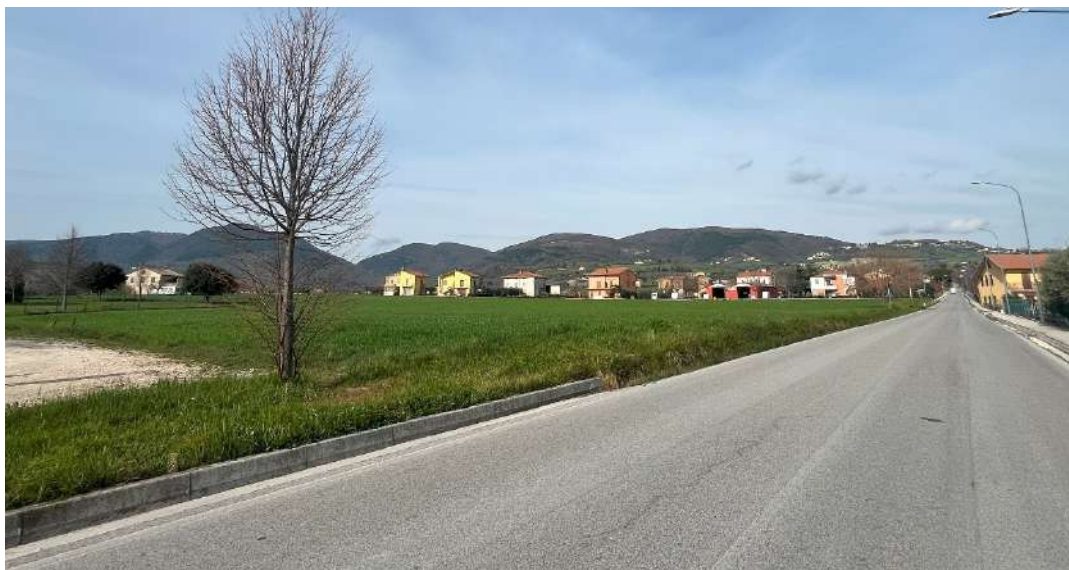
FOTO 1: VISTA VERSO NORD-OVEST DALLA STRADA PROVINCIALE 114
