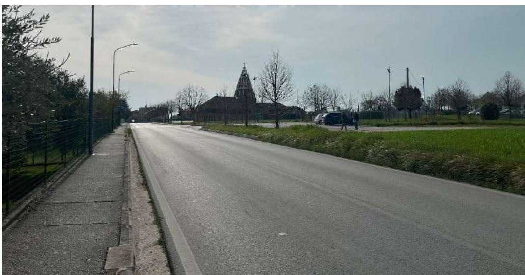
FOTO 3: VISTA VERSO EST - STRADA PROVINCIALE 114 ED INGRESSO AL COMPLESSO SCOLASTICO
