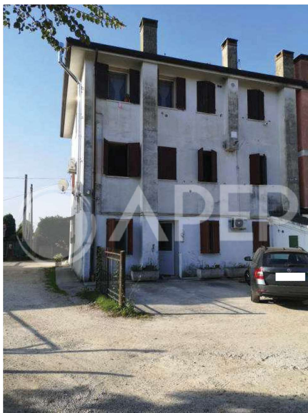
Part. 207 sub. 6 - vista nord
