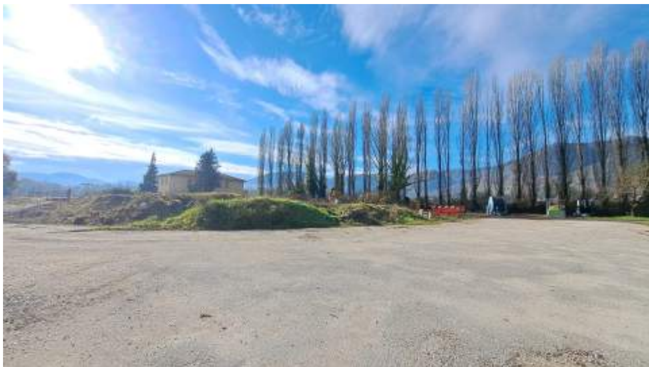
Vedute esterne dell'intera area (part. 73). In primo piano le macerie sul sedime del fabbricato ad uso enopolio (part. 74)
