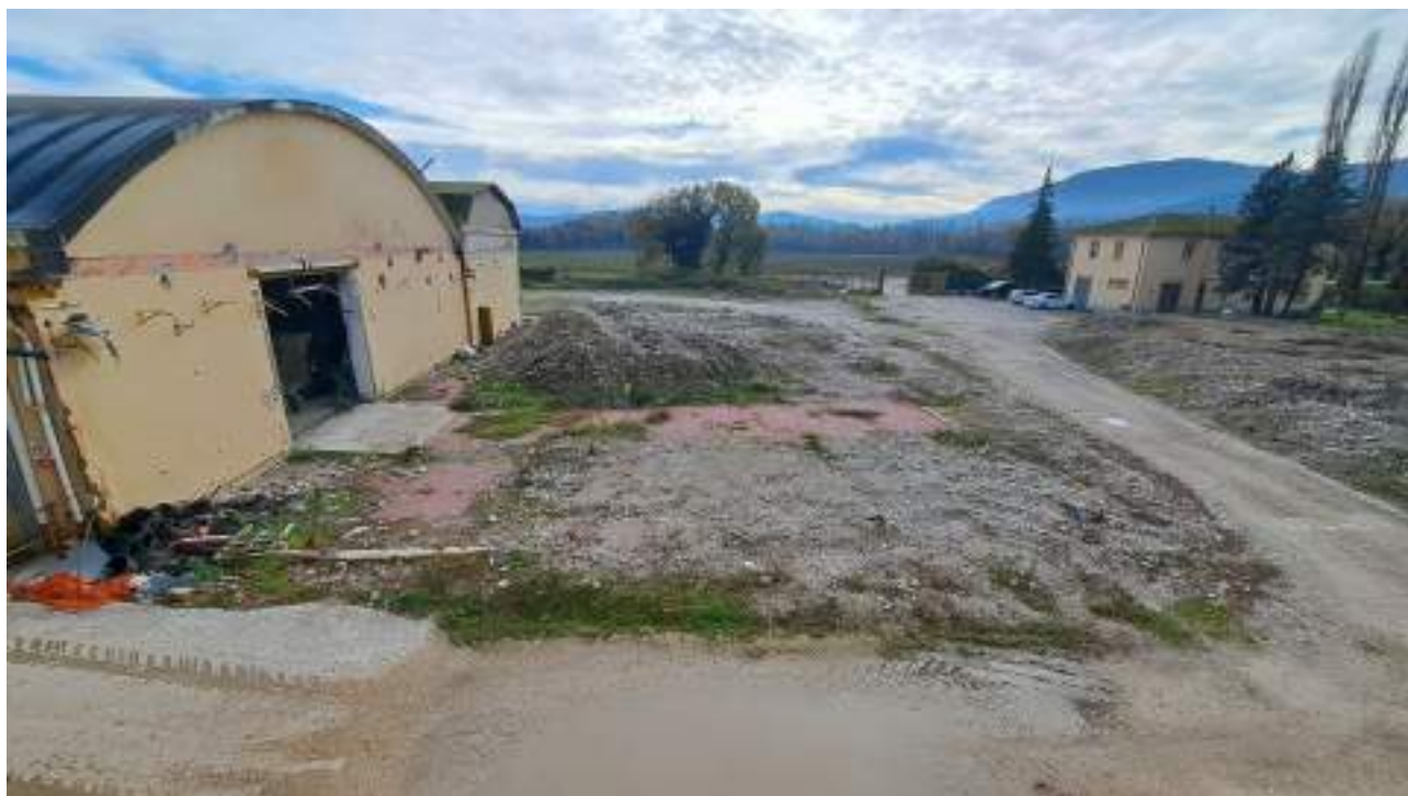
Vedute esterne dell'intera area (part. 73) su cui insistono i fabbricati ad uso magazzini part. 76 e 78 lato ovest. In primo piano macerie delle demolizioni di porzione della part. 78.
