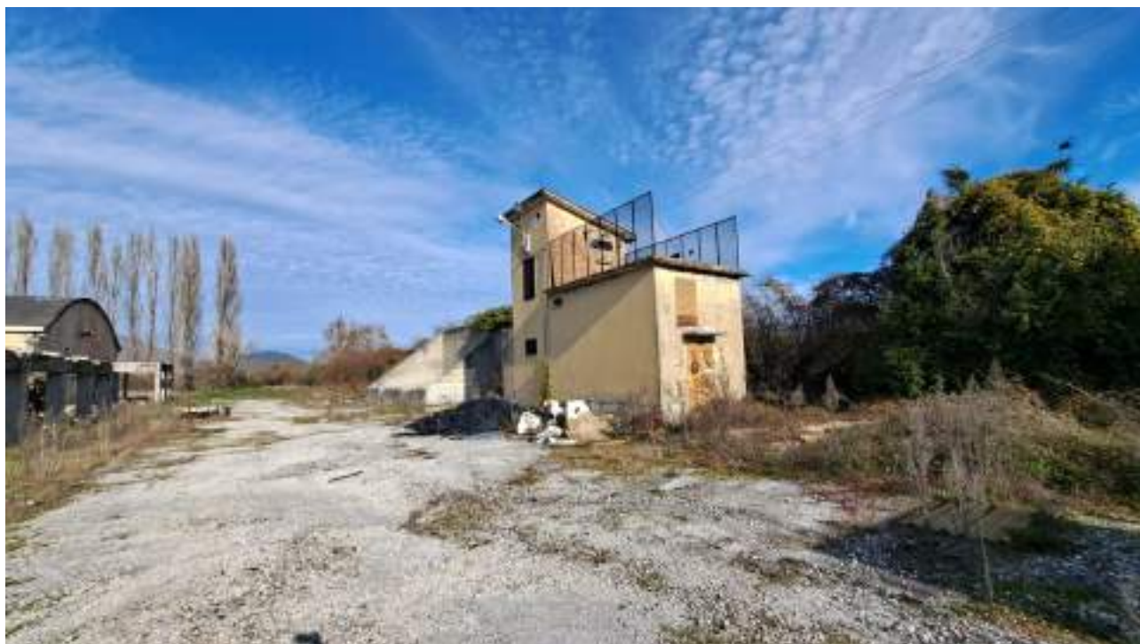
Vedute esterne part. 73 e 79 (sulla destra) – Edificio ad uso cabina elettrico
